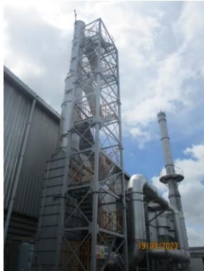
รูปที่ 1 ระบบบำบัดมลพิษทางอากาศ (Dust Collector)
